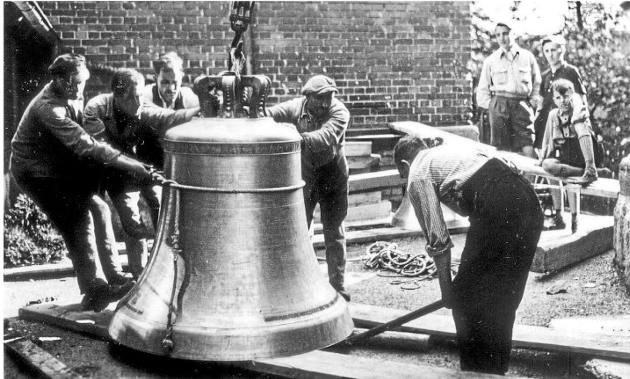
Im Jahr 1950 wurden im Stadtturm vier neue Glocken installiert.
